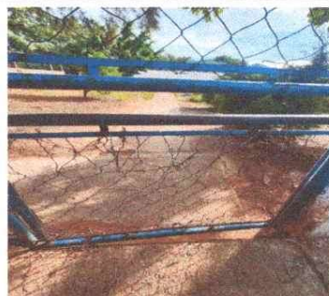
Foto 6: Mejoramiento de portón y malla frontal
