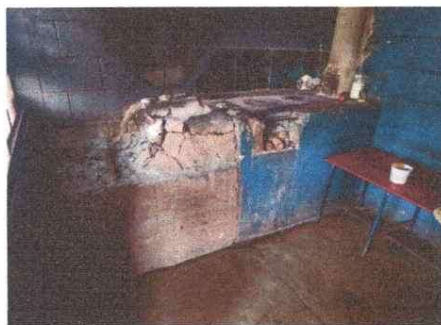
Foto 2: Mejoramiento de poyetón, demolición de pared
