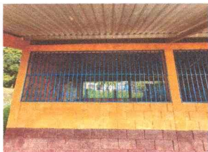
Foto 3: Mejoramiento de ventanas, pintura interior y exterior.
