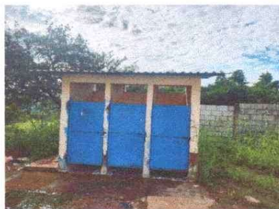
Foto 4: Mejoramiento de baños
