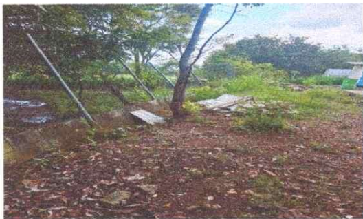
Foto 1: Mejoramiento de muro perimetral
