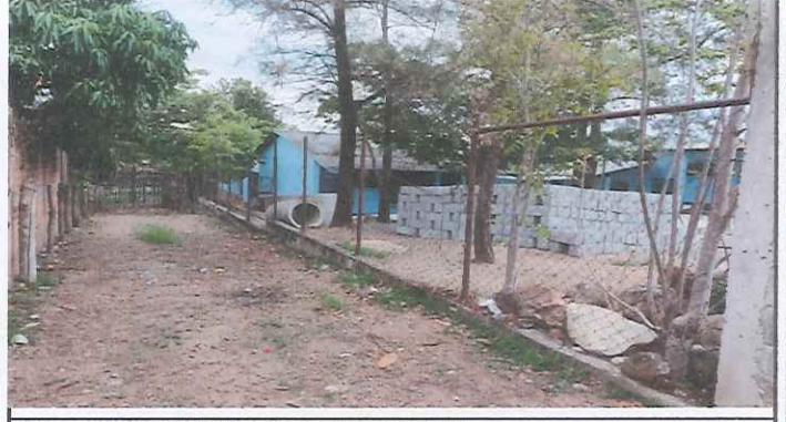
Foto 2: MEJORAMIENTO MURO PERIMETRAL
