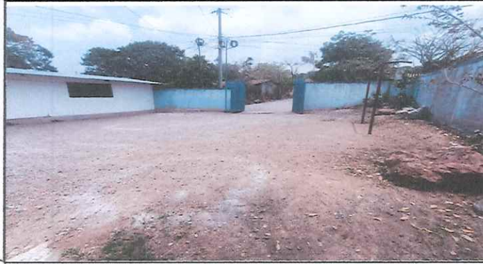
Foto 1: MEJORAMIENTO DEL PATIO, FUNDICION DE TORTA DE CEMENTO
