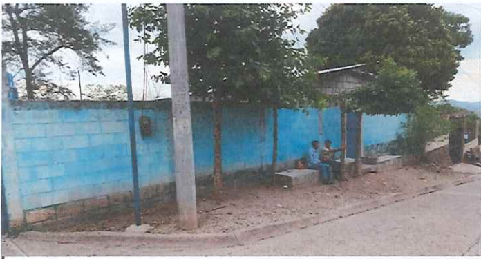
Foto 3: REPELLO CON MONOCAPA PARTE FRONTAL DE LA ESCUELA
