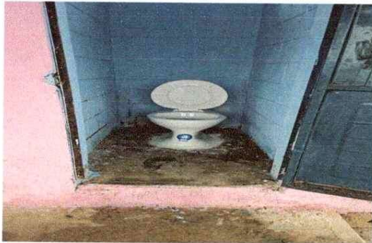
FOTO 1 Arreglo de baños
