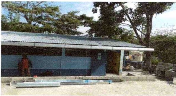
FOTO 3 Reparacion de canales
