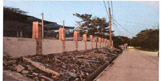
FOTO 4 Arreglo de malla
