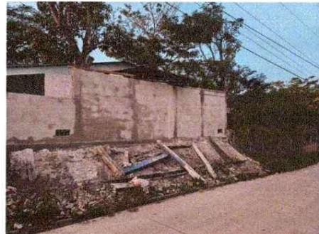
FOTO 6 Arreglo de repellos en muro
