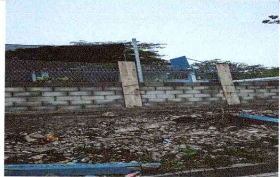
FOTO 2 Reparacion de muro
