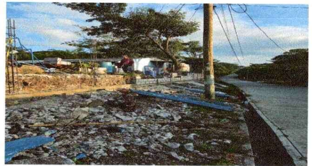
FOTO 4 Arreglo de acceso
