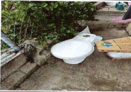
FOTO 1 Arreglo de baños
