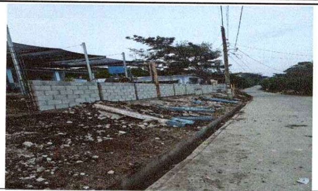
FOTO 2 Reparación de Muro
