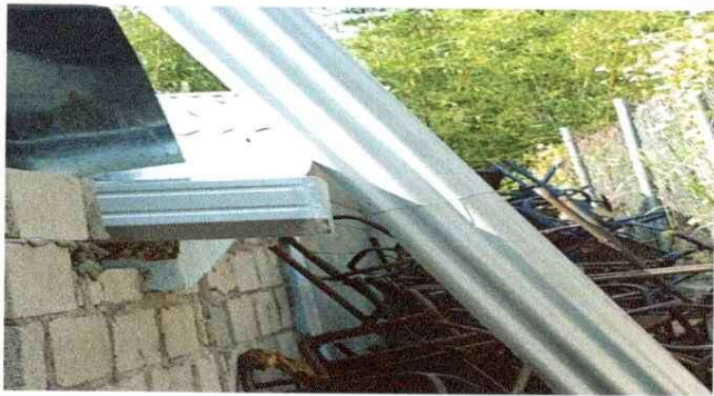
FOTO 3 Arreglo de canales
