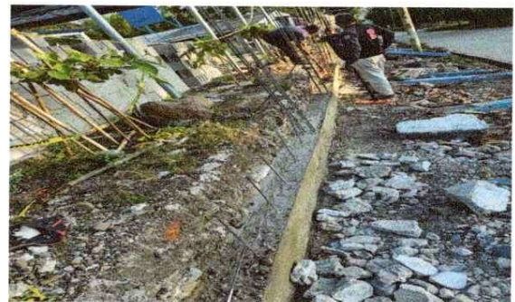
FOTO 6 Arreglo de repellos en muro
