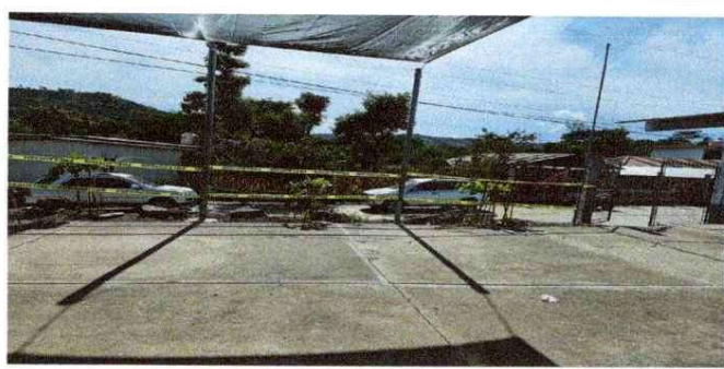
FOTO 5 AREGLO DE PORTON
