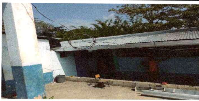
FOTO 3 AREGLO DE CANALES
