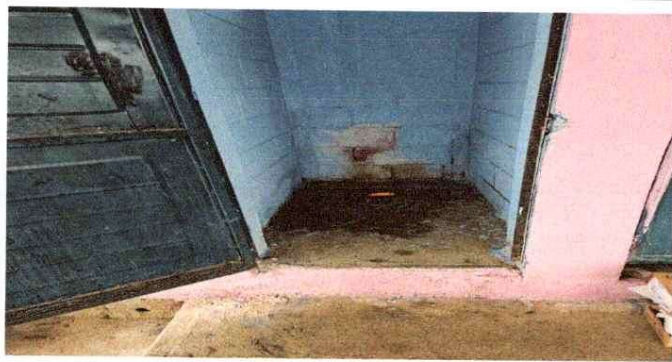
Foto 1: Areglo de baños
