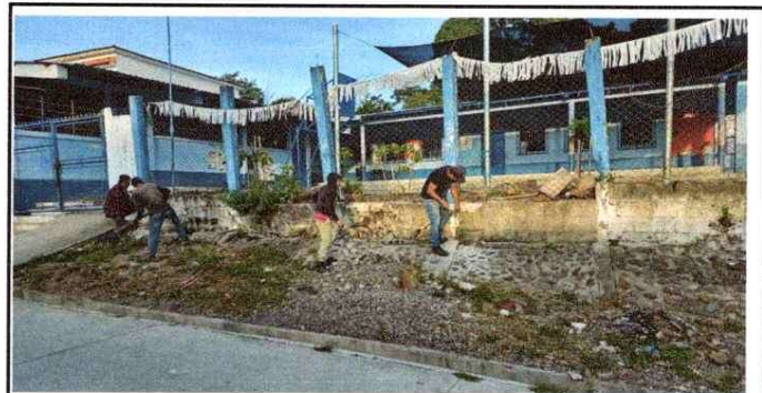
FOTO 6 AREGLO DE REPELLOS EN MURO
