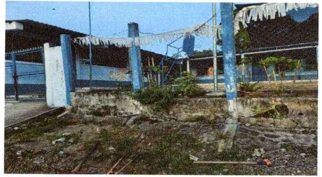
FOTO 2 REPARACION DE MURO
