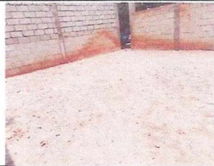
Foto 2: Colocacion de torta de cemento
