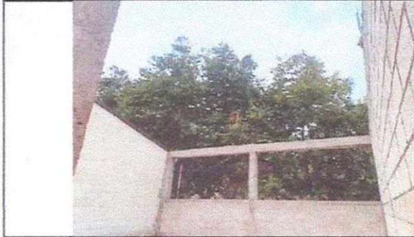
Foto 1: colocacion de lamina colocacion de balcones y puerta
