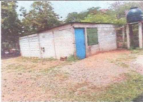
Foto 3: Levantamiento de pared y reconstruccion de techo
