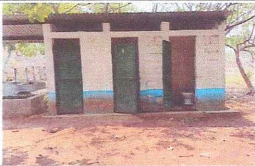
Foto 5: mejoramiento de puertas
