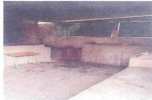
Foto 4: Sustitucion de piso
