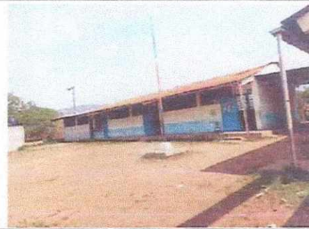
Foto 6: Pintura de muros exteriores
