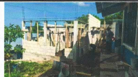
Foto 2: SUSTITUCIÓN TECTO, MEJORAMIENTO DE PAREDES, SUSTITUCIÓN DE ESTUFA RURAL, SUSTITUCIÓN DE PISO, INSTALACIÓN DE PUERTA E INSTALACIÓN DE ESTRUCTURA DE METAL DE VENTANA EN AREA DE COCINA
