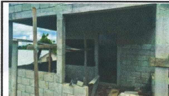
Foto 3: SUSTITUCIÓN TECTO, MEJORAMIENTO DE PAREDES, SUSTITUCIÓN DE ESTUFA RURAL, SUSTITUCIÓN DE PISO, INSTALACIÓN DE PUERTA E INSTALACIÓN DE ESTRUCTURA DE METAL DE VENTANA EN AREA DE COCINA
