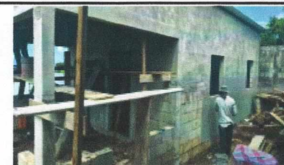
Foto 4: SUSTITUCIÓN TECTO, MEJORAMIENTO DE PAREDES, SUSTITUCIÓN DE ESTUFA RURAL, SUSTITUCIÓN DE PISO, INSTALACIÓN DE PUERTA E INSTALACIÓN DE ESTRUCTURA DE METAL DE VENTANA EN AREA DE COCINA
