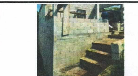
Foto 6: REPARACIÓN DE PISO DE TORTA DE CONCRETO
