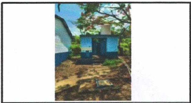
Foto 6: LIMPIEZA Y MEJORAMIENTO DE FOSA SEPTICA
