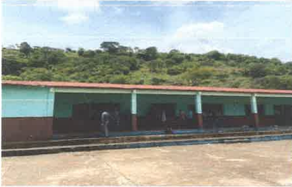
MODULO DE AULAS CON DAÑOS EN PISO, PUERTAS, SISTEMA ELECTRICO
