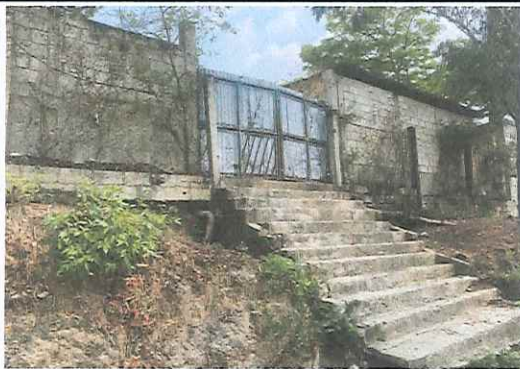
Foto 3: Altura aproximada que se hará de muro de contención.
