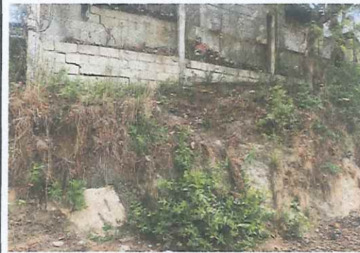
Foto 4: Área que se necesitará hacer movimiento de tierras.
