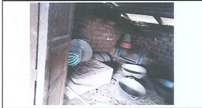
Foto 3: Interior cocina, lado izquierdo.
