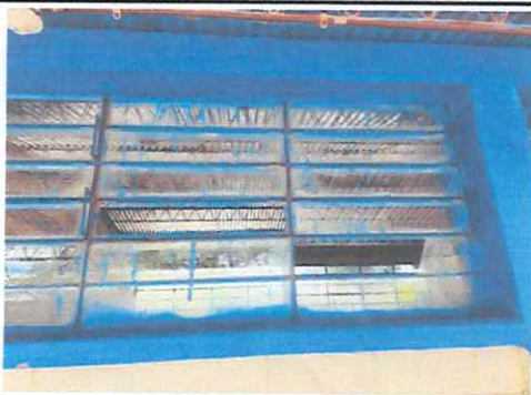
Foto 9: SUSTITUCIÓN DE VIDRIOS
