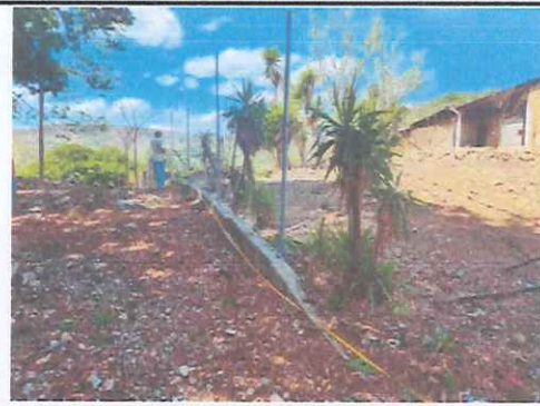
Foto 2: REPARACIÓN DE MURO PERIMETRAL DE BLOCK CON TUBO HG Y MALLA GALVANIZADA, SOLERAS INTERMEDIAS Y COLUMNAS
