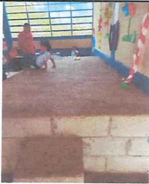
Foto 7: SUSTITUCIÓN DE TORTA DE CONCRETO POR PISO CERÁMICO
