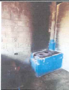
Foto 5: SUSTITUCIÓN DE ESTUFA RURAL CON CHIMENEA, PLANCHA DE METAL E INSTALACIÓN DE AZULEJO EN ÁREA DE COCINA
