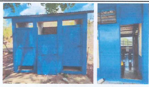
Foto 4: REPARACIÓN DE PUERTAS METÁLICAS EN SERVICIOS SANITARIOS Y MÓDULO DE AULAS
