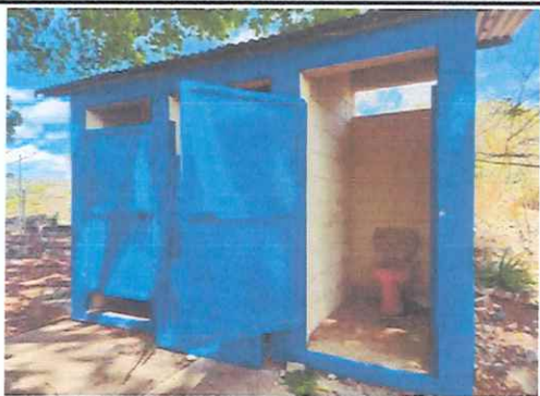
Foto 3: SUSTITUCIÓN DE LETRINAS POR BAÑOS LAVABLES, MEJORAMIENTO DE FOSA SÉPTICAS E INSTALACIÓN DE TUBERÍA PARA DRENAJE EN SERVICIOS SANITARIOS
