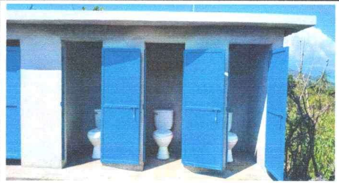
Foto 2: SUSTITUCIÓN BAÑOS LAVABLES, INSTALACIÓN DE DEPOSITO DED AGUA, SUSTITUCIÓN DE PUERTAS, MEJORAMIENTO DE PAREDES, MEJORAMIENTO DE FOSA SEPTICA E INSTALACIÓN DE TUBERIA DE AGUA POTABLE Y DRENAJES EN SERVICIOS
