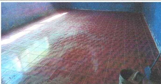
Foto 5: SUSTITUCIÓN DE PISO DE GRANITO
