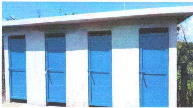
Foto 1: SUSTITUCIÓN BAÑOS LAVABLES, INSTALACIÓN DE DEPOSITO DED AGUA, SUSTITUCIÓN DE PUERTAS, MEJORAMIENTO DE PAREDES, MEJORAMIENTO DE FOSA SEPTICA E INSTALACIÓN DE TUBERIA DE AGUA POTABLE Y DRENAJES EN SERVICIOS
