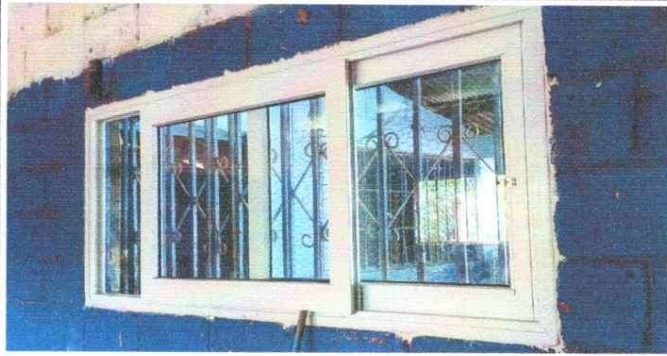
Foto 7: SUSTITUCIÓN DE VIDRIOS EN VENTANALES
