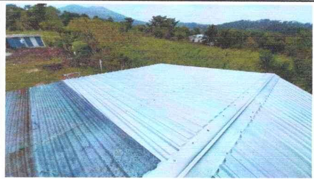
Foto 8: SUSTITUCIÓN DE LAMINA, POR LAMINA TROQUELADA ALUZINC CALIBRE 26
