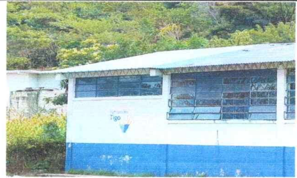
Foto 10: SUSTITUCIÓN DE LAMINA, POR LAMINA TROQUELADA ALUZINC CALIBRE 26
