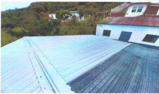
Foto 9: SUSTITUCIÓN DE LAMINA, POR LAMINA TROQUELADA ALUZINC CALIBRE 26
