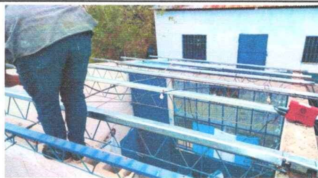
Foto 8: SUSTITUCIÓN DE LAMINA, POR LAMINA TROQUELADA ALUZINC CALIBRE 26
