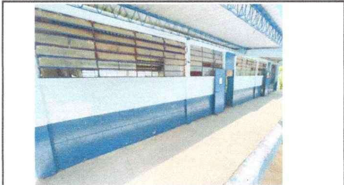
Foto 7: SUSTITUCIÓN DE VIDRIOS EN VENTANALES
