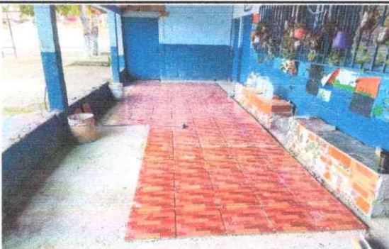
Foto 5: SUSTITUCIÓN DE PISO DE GRANITO
