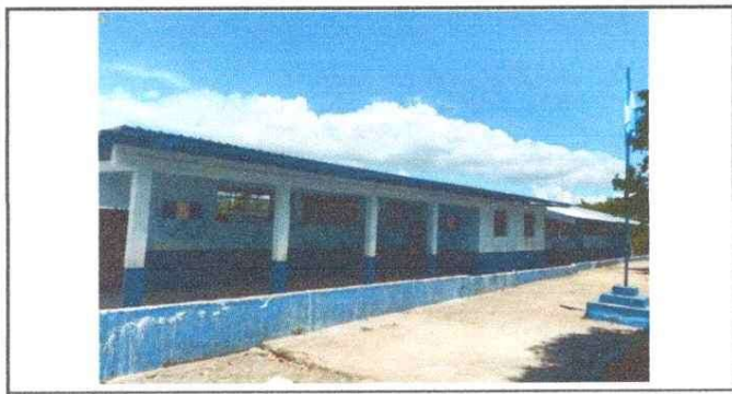
Foto 11: PINTURA EN MUROS EXTERIORES E INTERIORES
