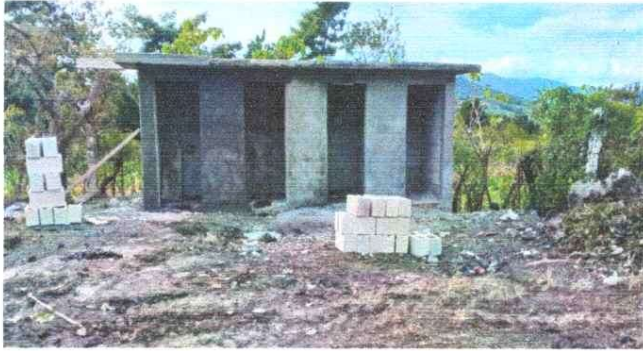
Foto 1: SUSTITUCIÓN BAÑOS, INSTALACIÓN DE DEPOSITO DED AGUA, SUSTITUCIÓN DE PUERTAS, MEJORAMIENTO DE PAREDES, MEJORAMIENTO DE FOSA SEPTICA E INSTALACIÓN DE TUBERIA DE AGUA POTABLE Y DRENAJES EN SERVICIOS
