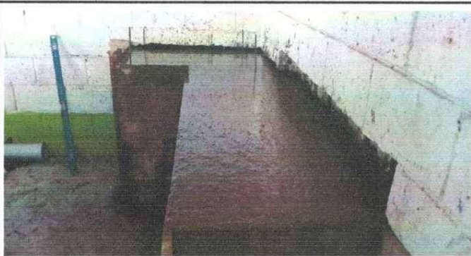
Foto 3: SUSTITUCIÓN DE ESTUFA RURAL CON CHIMENEA, PLANCHA DE METAL E INSTALACIÓN DE AZULEJO Y MUEBLE DE COCINA MAS INSTALACIÓN DE AZULEJO EN AREA DE COCINA.
