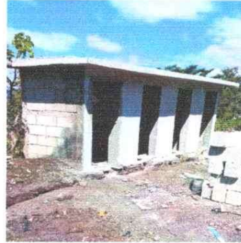
Foto 2: SUSTITUCIÓN BAÑOS, INSTALACIÓN DE DEPOSITO DED AGUA, SUSTITUCIÓN DE PUERTAS, MEJORAMIENTO DE PAREDES, MEJORAMIENTO DE FOSA SEPTICA E INSTALACIÓN DE TUBERIA DE AGUA POTABLE Y DRENAJES EN SERVICIOS
