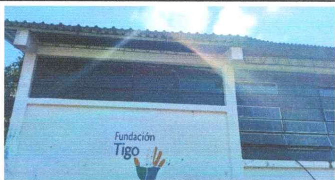
Foto 7: SUSTITUCIÓN DE VIDRIOS EN VENTANALES
