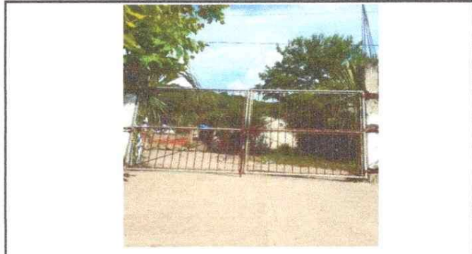
Foto 8: REPARACIÓN DE PORTÓN PRINCIPAL
