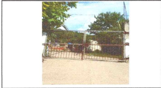
Foto 8: REPARACIÓN DE PORTÓN PRINCIPAL
