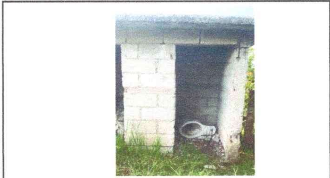
Foto 2: SUSTITUCIÓN DE BAÑOS LAVABLES, INSTALACIÓN DE DEPOSITO DE AGUA, SUSTITUCIÓN DE PUERTAS, MEJORAMIENTO DE PAREDES, MEJORAMIENTO DE FOSA SEPTICA E INSTALACIÓN DE TUBERIA DE AGUA POTABLE Y DRENAJES EN SERVICIOS SANITARIOS.
