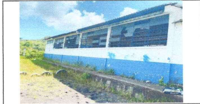
Foto 6: SUSTITUCIÓN DE VIDRIOS EN VENTANALES
