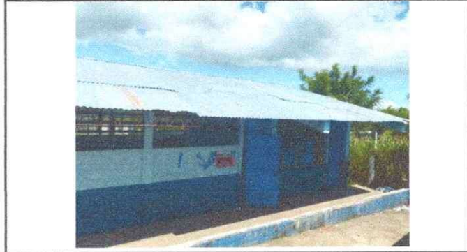
Foto 10: SUSTITUCIÓN DE LÁMINA, POR LAMINA TROQUELADA ALUZINC CALIBRE 26
