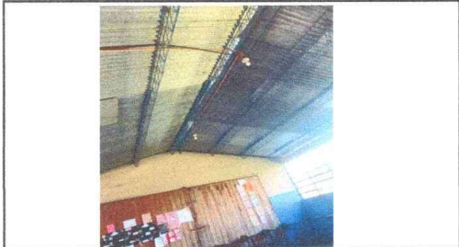
Foto 9: SUSTITUCIÓN DE LÁMINA, POR LAMINA TROQUELADA ALUZINC CALIBRE 26
