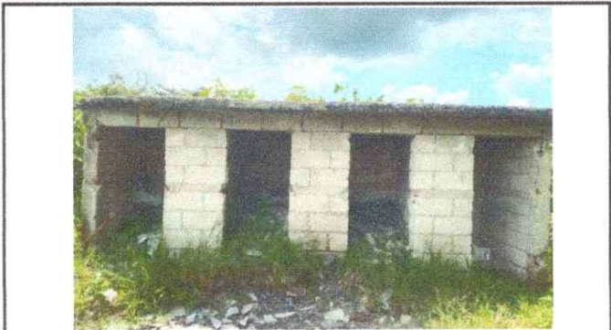
Foto1: SUSTITUCIÓN DE BAÑOS LAVABLES, INSTALACIÓN DE DEPOSITO DE AGUA, SUSTITUCIÓN DE PUERTAS, MEJORAMIENTO DE PAREDES, MEJORAMIENTO DE FOSA SEPTICA E INSTALACIÓN DE TUBERIA DE AGUA POTABLE Y DRENAJES EN SERVICIOS SANITARIOS.
