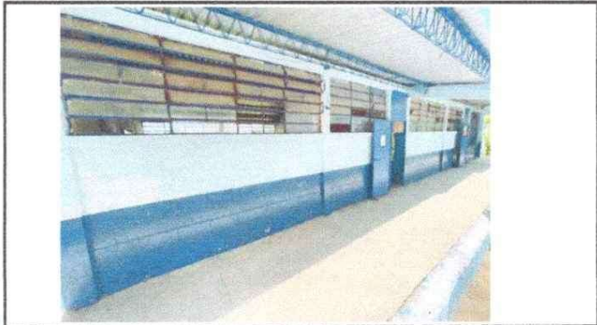
Foto 7: SUSTITUCIÓN DE VIDRIOS EN VENTANALES
