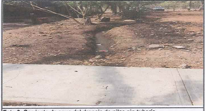
Foto 6: Corriente de agua del drenaje de pilas sin tubería
