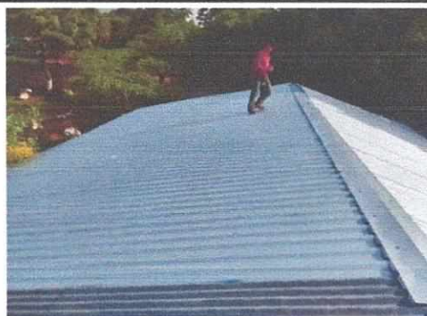
Foto 2: SUSTITUCIÓN DE LÁMINA EN ESTRUCTURA DE METAL POR LÁMINA TROQUELADA EN MODULO DE AULAS
