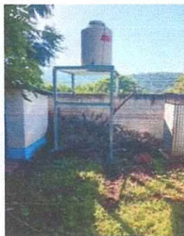
Foto 5: INSTALACIÓN DE DEPOSITO DE AGUA EN SERVICIOS SANITARIOS
