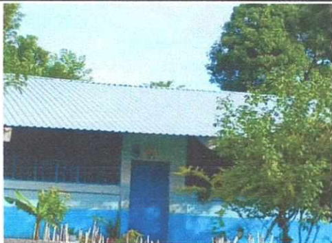
Foto 1: SUSTITUCIÓN DE LÁMINA EN ESTRUCTURA DE METAL POR LÁMINA TROQUELADA EN MODULO DE AULAS
