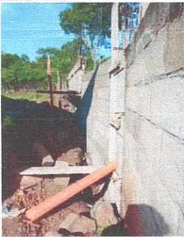
Foto 11: MEJORAMIENTO DE MURO PERIMETRAL
