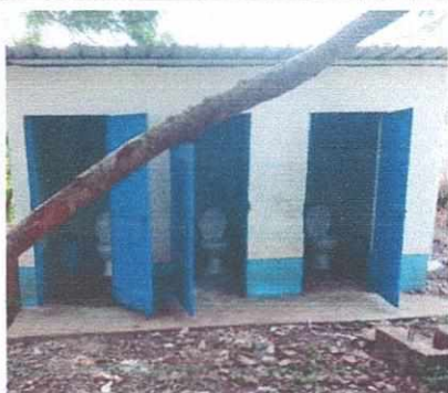
Foto 3: SUSTITUCIÓN DE INODOROS, MEJORAMIENTO Y LIMPIEZA DE FOSA SEPTICA, INTALACIÓN DE DEPOSITO DE AGUA Y REPARACIÓN DE PUERTAS EN SERVICIOS SANITARIOS
