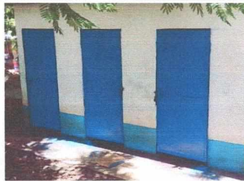
Foto 4: SUSTITUCIÓN DE INODOROS, MEJORAMIENTO Y LIMPIEZA DE FOSA SEPTICA, INTALACIÓN DE DEPOSITO DE AGUA Y REPARACIÓN DE PUESTAS EN SERVICIOS SANITARIOS
