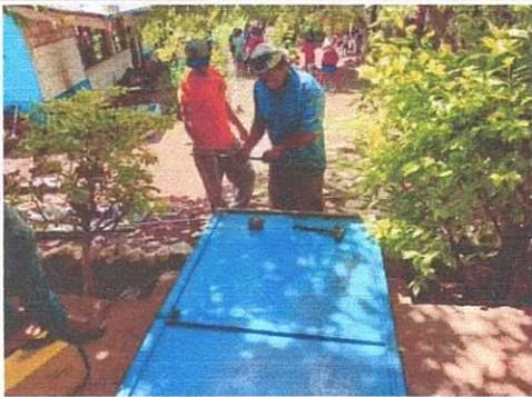
Foto 9: MANTENIMIENTO A ESTRUCTURA (LIJADO, CAMBIO DE TUBO, CEPILLADO, SUJECIONES, APLICACIÓN DE PINTURA) EN PUERTA
