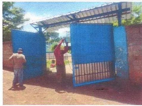
Foto 10: MANTENIMIENTO A ESTRUCTURA (LIJADO, CAMBIO DE TUBO, CEPILLADO, SUJECIONES, APLICACIÓN DE PINTURA) EN PORTO PRINCIPAL
