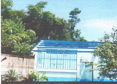
Foto 1: SUSTITUCIÓN DE LÁMINA EN ESTRUCTURA DE METAL POR LÁMINA TROQUELADA EN MODULO DE AULAS
