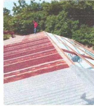
Foto 2: SUSTITUCIÓN DE LÁMINA EN ESTRUCTURA DE METAL POR LÁMINA TROQUELADA EN MODULO DE AULAS
