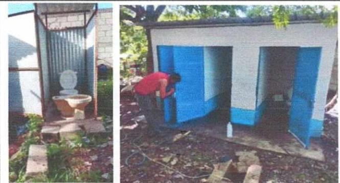
Foto 4: SUSTITUCIÓN DE INODOROS, MEJORAMIENTO Y LIMPIEZA DE FOSA SEPTICA, INTALACIÓN DE DEPOSITO DE AGUA Y REPARACIÓN DE PUESTAS EN SERVICIOS SANITARIOS
