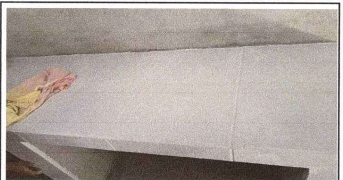
Foto 2. Remodelación de polleton No. 1 con mesa de trabajo y hornillas
