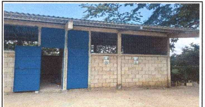
Foto 4; Remozamiento instalacion de puertas aulas
