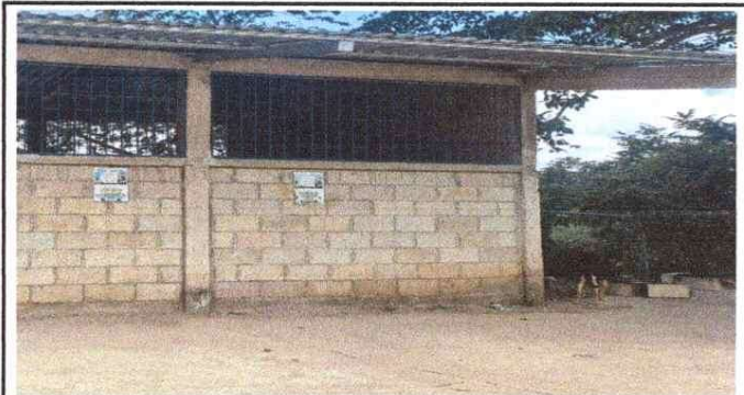
Foto 3: Remozamiento de techado aulas
