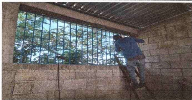
Foto 3: Colocacion de balcones
