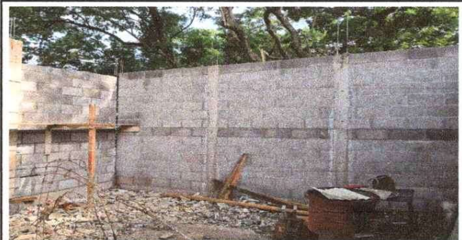
Foto 6: Mejoramiento de techado aulas
