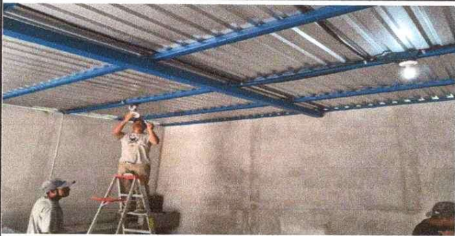
Foto 1: Mejoramiento sistema electrico
