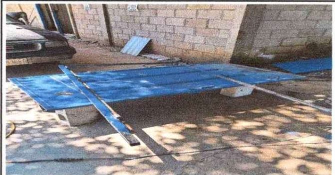
Foto 4: Mejoramiento de puertas aulas
