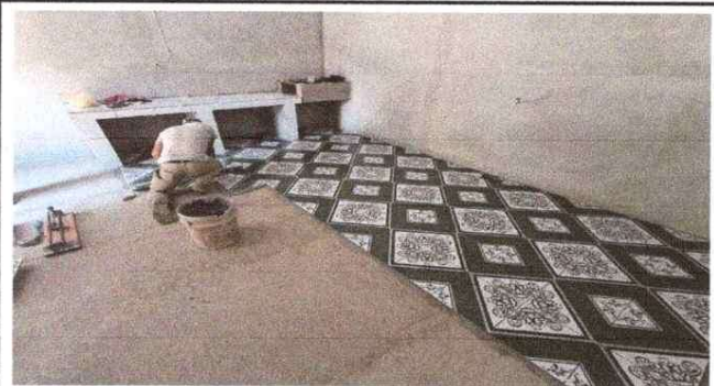
Foto 2: Mejoramiento de piso
