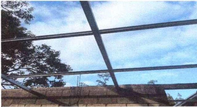
Foto1: Sustitución de estructura
