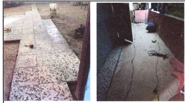
Foto 2: Sustitución de piso de cemento por granito
