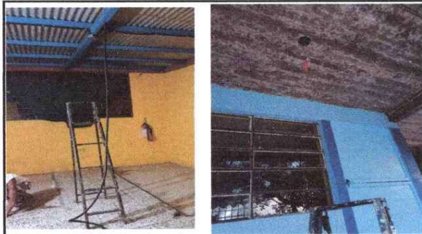
Foto 3: Reparación del sistema eléctrico
