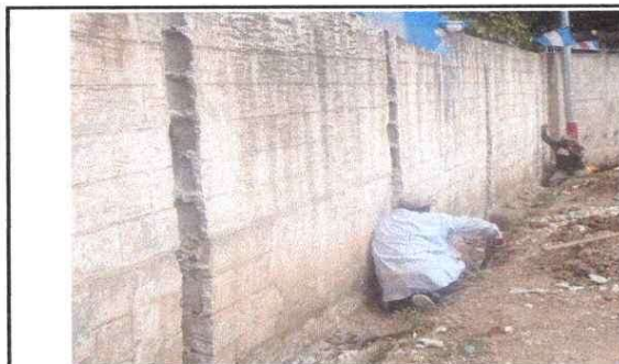
Foto 5: Reparación de muro perimetral
