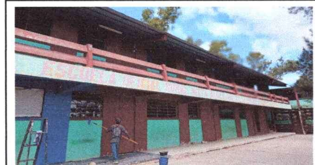
Foto 4: Pintura de exteriores
