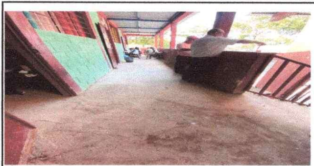
Foto 2: Sustitución de piso de cemento por granito y canal
