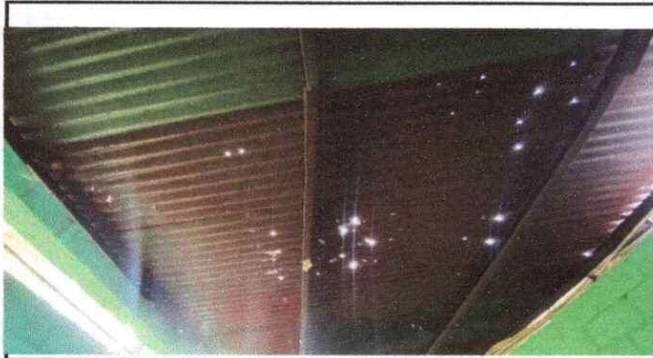
Foto1: Sustitución de estructura y lámina
