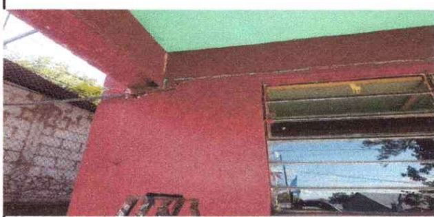
Foto 3: Reparación del sistema eléctrico
