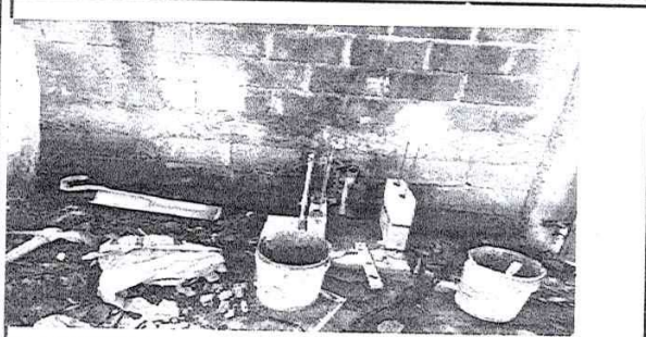
Foto 7: Mesitas en proceso para que se sostengan los 3 lavamanos
