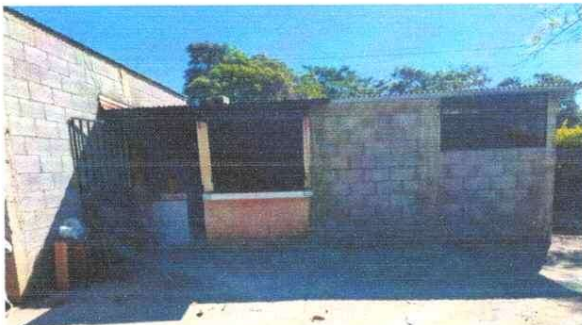
Foto.5 Ampliacion de Cocina
