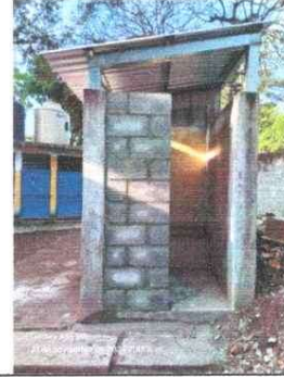
Foto 2. Reparación de Migitorio
