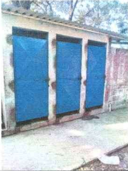
Foto 1. Baños reparación de techo y puertas
