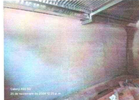
Foto.6 Sustitucion de canal de agua y repello de pared
