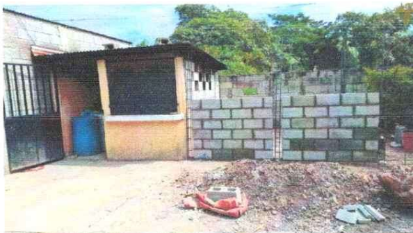
Foto 5. Ampliacion de Cocina
