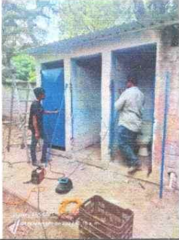
Foto 1. Reparacion de techo de baños y purtas
