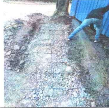
Foto 4. Rampa de ingreso al establecimiento
