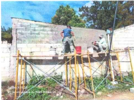
foto. Reparacion de pared de muro que es utilizado de aula
