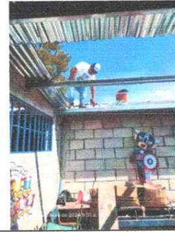
foto 6. Sustitución de canal de agua y repello de pared
