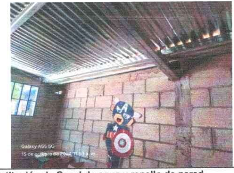
Foto. 6 Sustitución de Canal de agua y repello de pared
