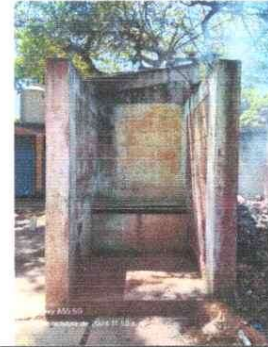
foto 2: Reparación de Migitorio
