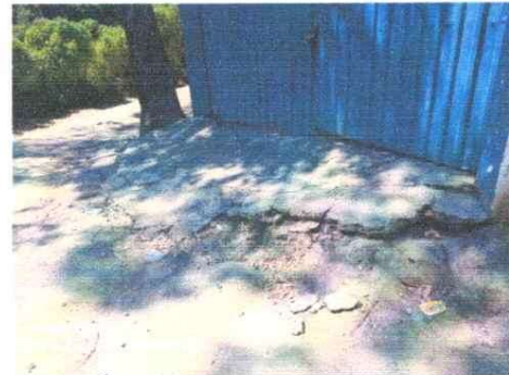
Foto.4 Rampa de ingreso al Establecimiento
