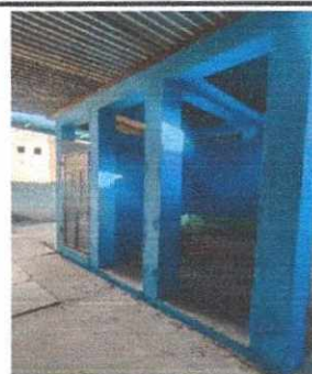
Foto 6: MANTENIMIENTO Y REPARACIÓN DE MINGITORIO
