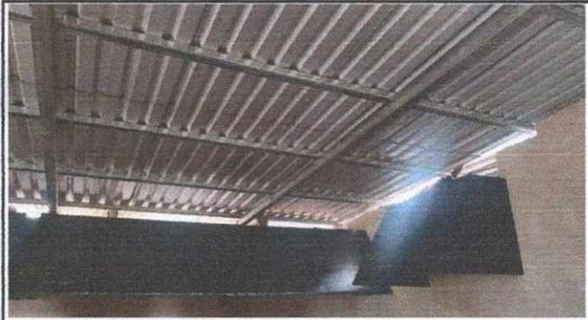
Foto 3: INSTALACIÓN DE TECHO CON ESTRUCTURA METALICA Y LAMINA EN AREA DE COCINA
