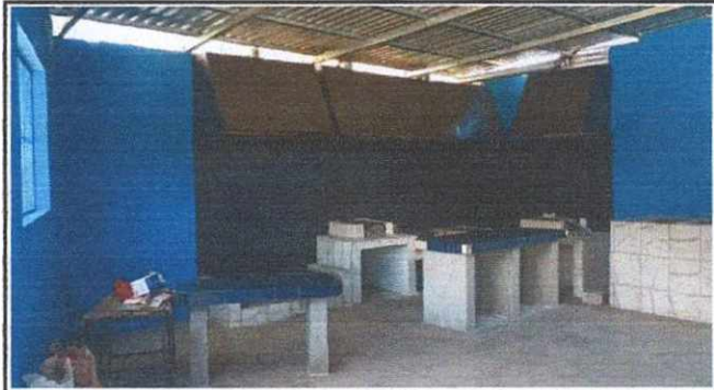
Foto 4: MEJORAMIENTO DE ESTUFA RURAL, INSTALACIÓN DE ACULEJO, SISTEMA DE EXTRACCIÓN DE HUMO, MEJORAMIENTO DE MUEBLE DE COCINA Y PAREDES EXISTENTES EN AREA DE COCINA
