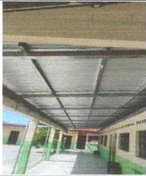
Foto1: INSTALACIÓN DE TECHO CON ESTRUCTURA METALICA Y LAMINA TROQUELADA EN MODULO DE AULAS
