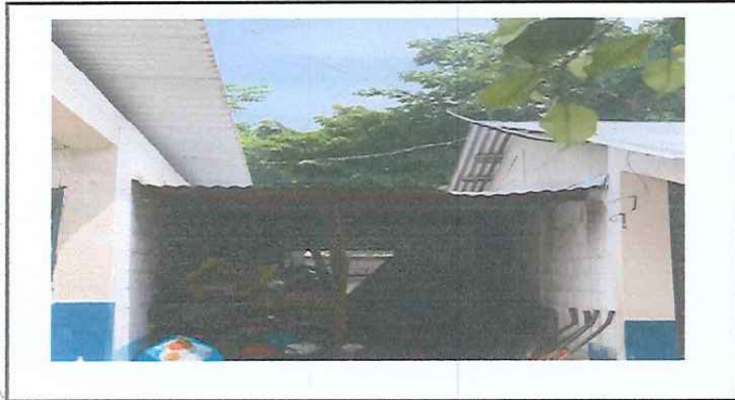
Foto 1: reparación de techo.
