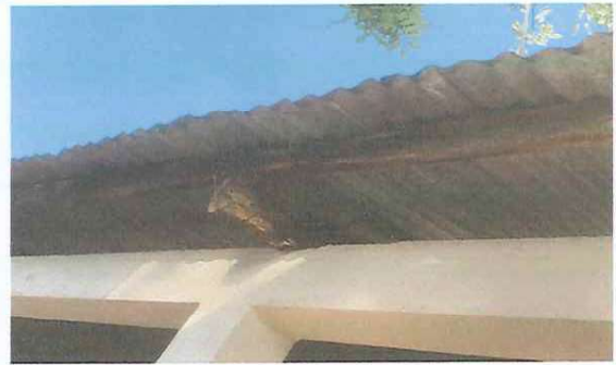
Foto 2: Parte frontal del aula
