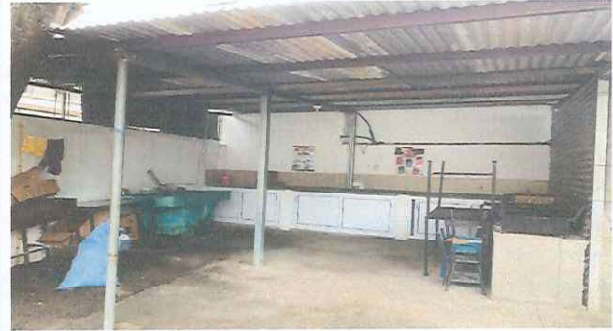
Foto 2: Sustitución de piso de concreto por piso cerámico y colocación de azulejos.
