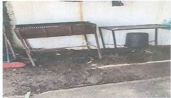
Foto 4: Construcción de piso de concreto.
