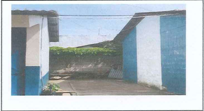
Foto 2: colocación de techo
