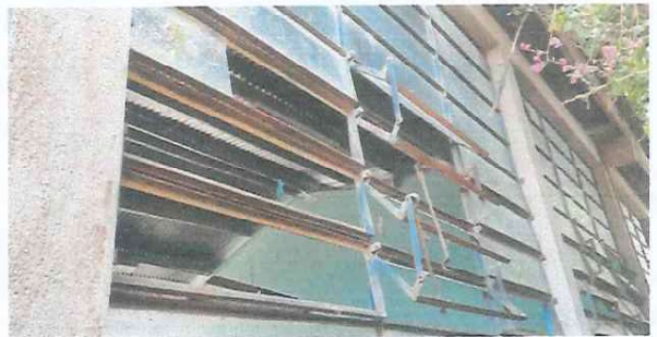
sustitución de vidrios.
