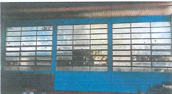
Foto 5: sustitución de vidrios.
