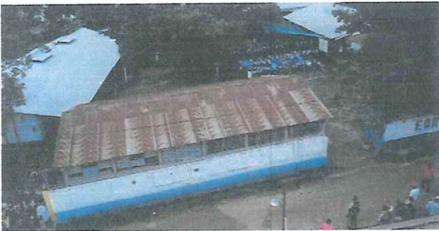
Foto1: Vista aérea del techo a remozar con pintura, incluye dos aulas, ala Este.
