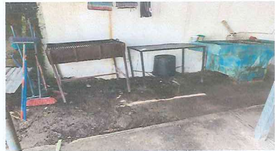
Foto 4: mejoramiento de piso.
