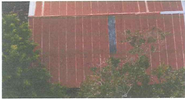
Foto1: Vista aérea del techo a sustituir.
