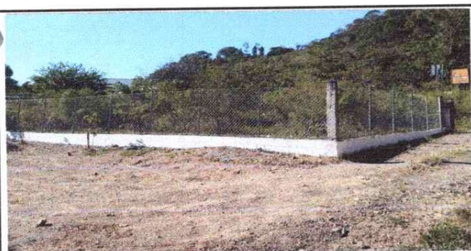
Reparación de malla galvanizada
