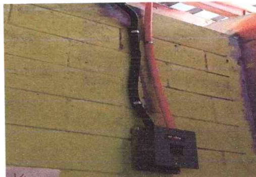
Sustitución de flipones y tablero
