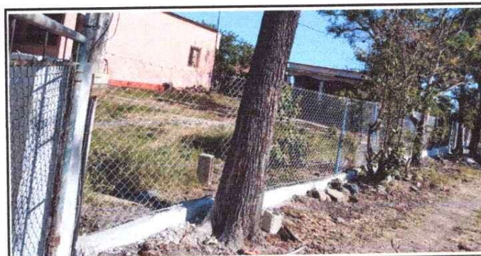
Reparación de Muro Perimetral
