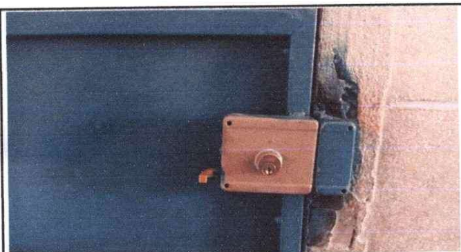
Sustitución de Chapas
