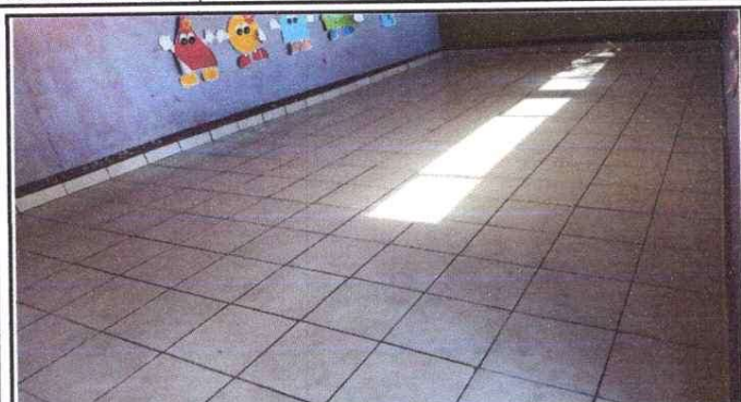
Reparación de torta en mal estado
