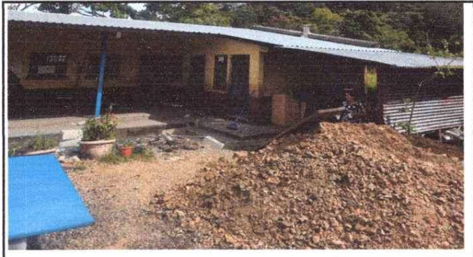
REPARACIÓN DE TECHO
