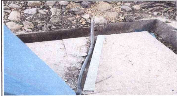
REPARACIÓN DE SISTEMA ELÉCTRICO
