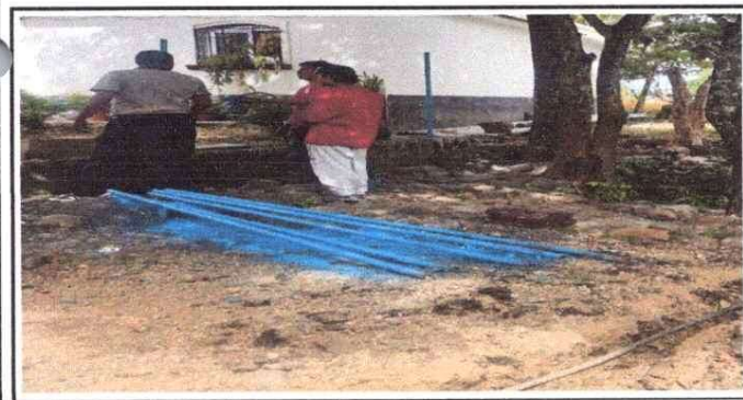
MEJORAMIENTO DE MURO PERIMETRAL
