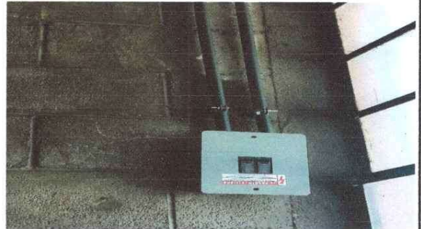
Foto 4: Termination de instalacion electrica
