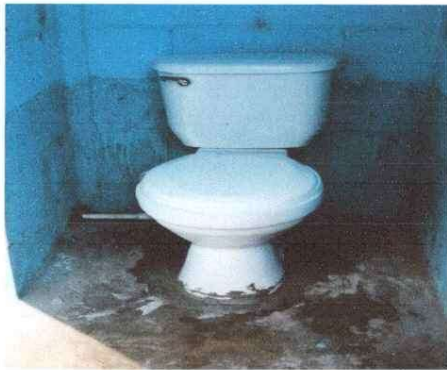
Foto 3: Termination de instalacion de sanitario
