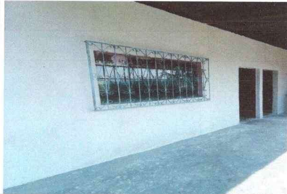
Foto 1: Termination de fundicion de concreto
