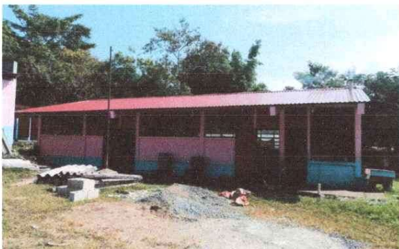
Foto 5: Termination de instalacion de techo
