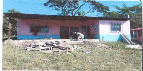
Foto 2 : Termination de levantado de pared para corredor
