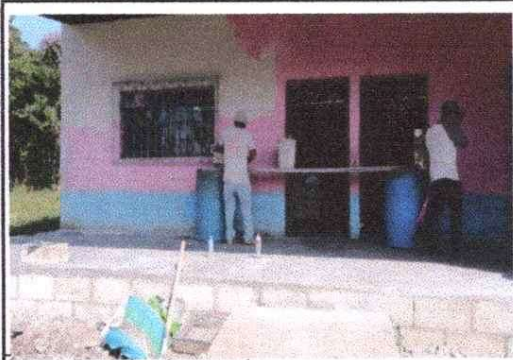
Foto 1: Fundición de concreto
