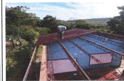
Foto 5: Instalación de techo
