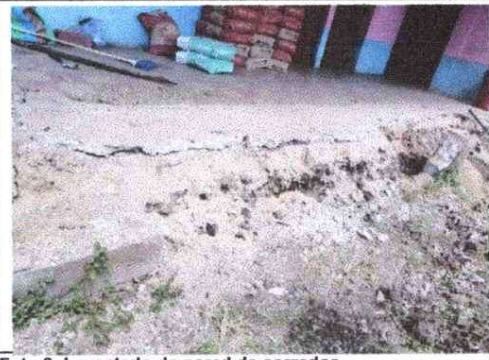
Foto 2: Levantado de pared de corredor
