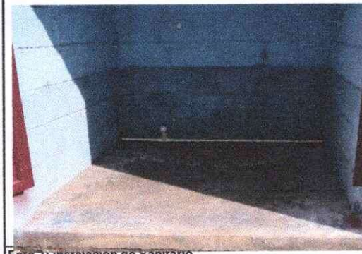
Foto 3: Instalación de Sanitario
