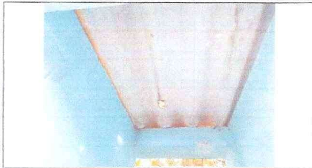
Foto 1: Instalación de techo del sanitario
