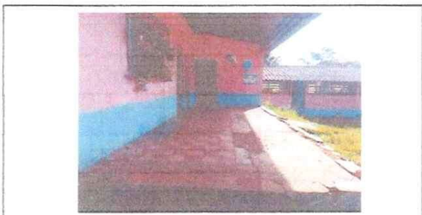
Foto 5: Fundición de piso de concreto
