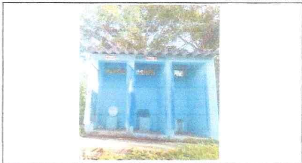
Foto 2: Instalación de inodoros
