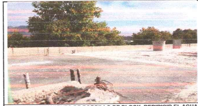
Foto 6: LEVANTAMIENTO DE BORDILLO DE BLOCK REDIRIGIR EL AGUA PLUVIAL HACIA LAS GARGOLAS Y QUE ESTA NO DESCienda POR LA PAREDES
