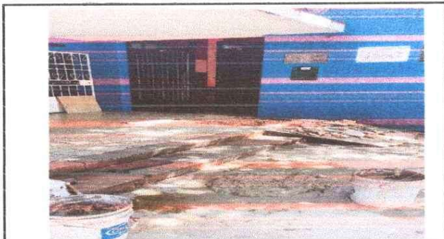
Foto 3: REMOZAMIENTO DE PISO CERAMICO EN EL INGRESO AL SALÓN PRINCIPAL EVITANDO EL HUNDIMIENTO Y RESGUARDANDO QUE INGRESAN PARA EVITAR UN ACCIDENTE
