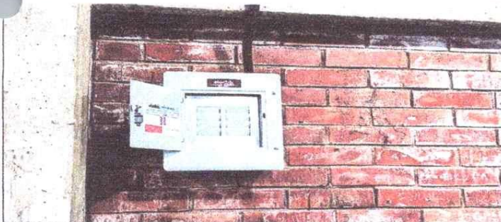
Foto 3: Instalacion de tableros
