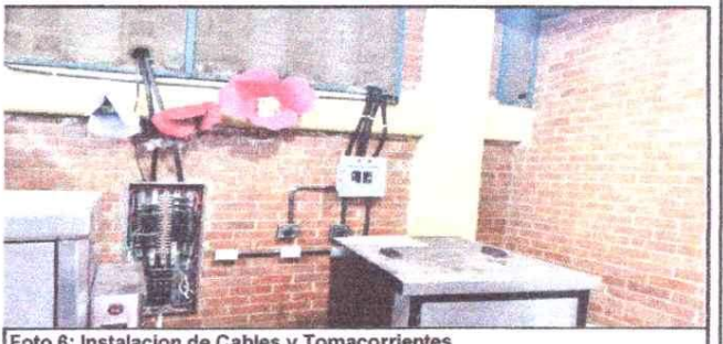
Foto 6: Instalacion de Cables y Tomacorrientes
