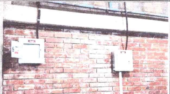
Foto 2: Instalacion de tableros
