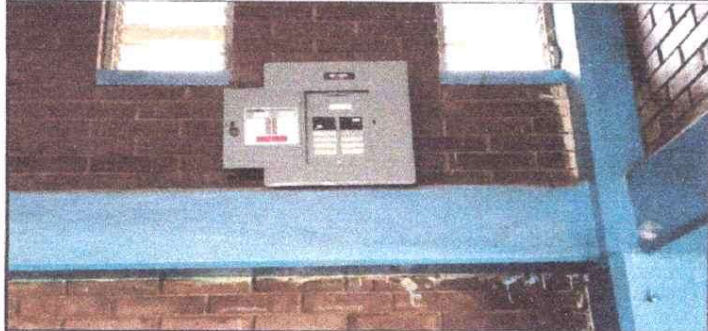
Foto 1: Instalacion de tableros
