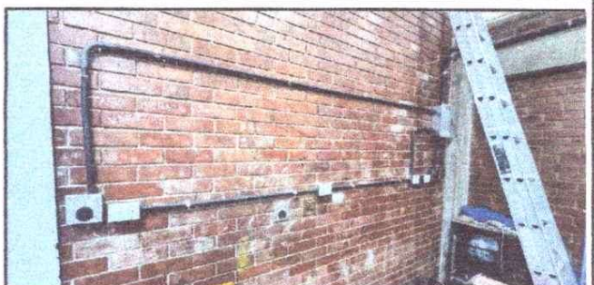
Foto 4: Instalacion de Cables y Tomacorrientes
