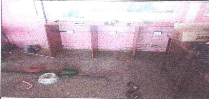
Foto 1: Sustitucion de cables
