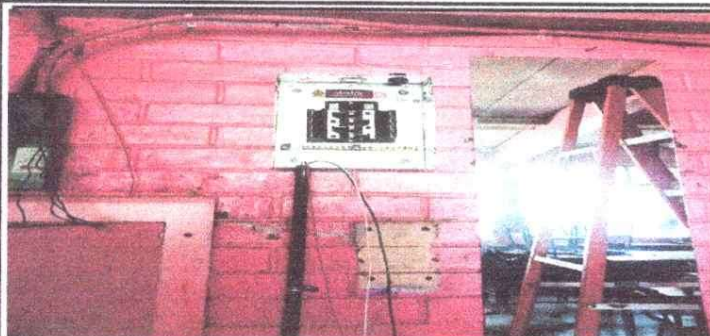
Foto 1: sustitucion de Tableros
