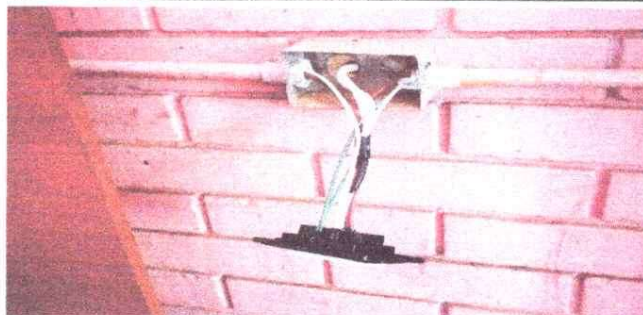
Foto 4: sustitucion de toma corriente
