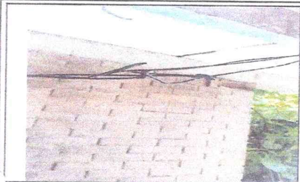
Foto 1: Cambio de cable de cometida
