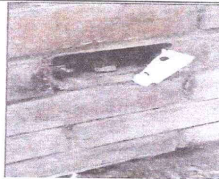
Foto 10: Sustrucción de tomacorrientes
