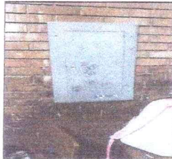
Foto 18: Sustitución de tablero de flipones
