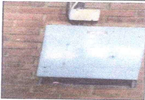
Foto 9: Sustrucción de tableros
