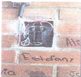
Foto 17: Sustitución de tomacorrientes
