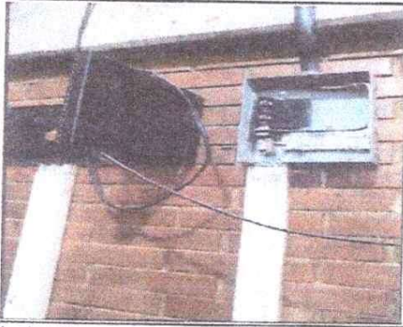
Foto 7: Sustrucción de tableros
