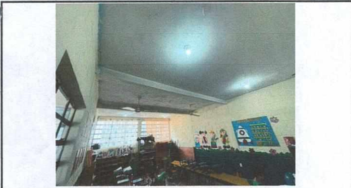
Foto 29: Fase final de instalación eléctrica.
