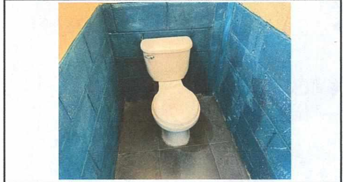
Foto 28: Fase final de instalación de servicios sanitarios.
