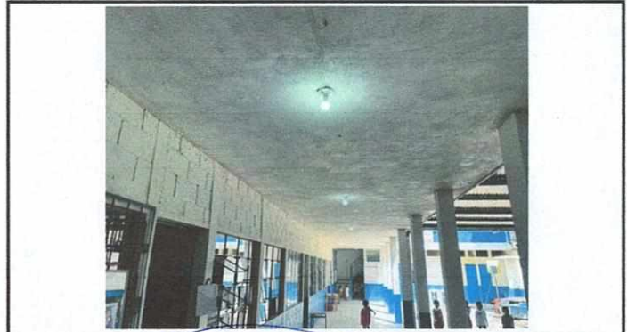
Foto 30: Fase final de instalación eléctrica.
