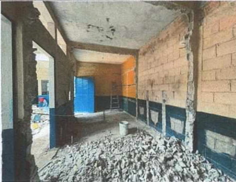
Foto 11: Panorámica de demolición de muros de división de cocina y servicios sanitarios.
