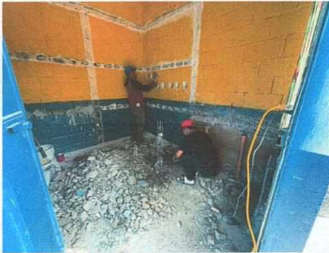
Foto 9: Demolición de de área de cocina y pila.
