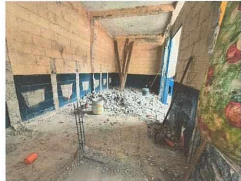
Foto 10: Demolición de de muros de división de cocina y servicios sanitarios.
