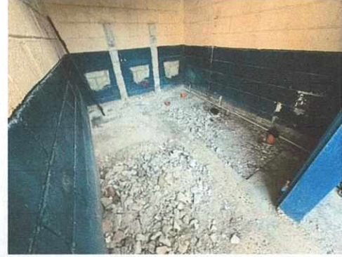
Foto 8: Demolición de servicios sanitarios.
