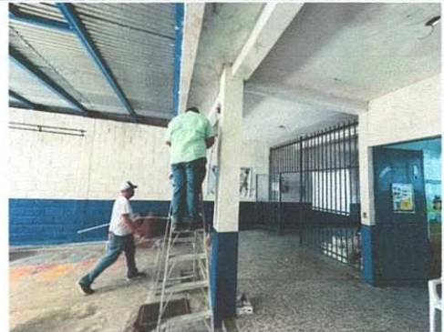
Foto 12: Reemplazo de instalaciones electricas.
