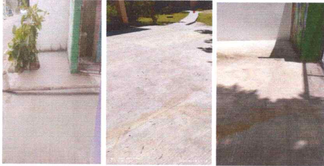
Foto 7: LOSA DE PATIO: Reparacion de la losa del patio principal
