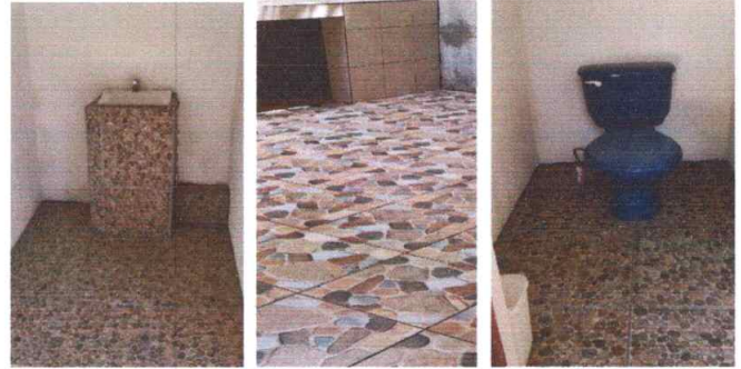
Foto 4: PISO: Sustitucion de piso en la cocina y en los baños
