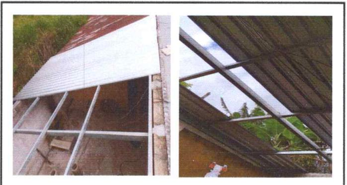
Foto 2: ESTRUCTURA DE TECHO: sustitucion de la misma en la cocina y los baños debido a que estan en malas condiciones
