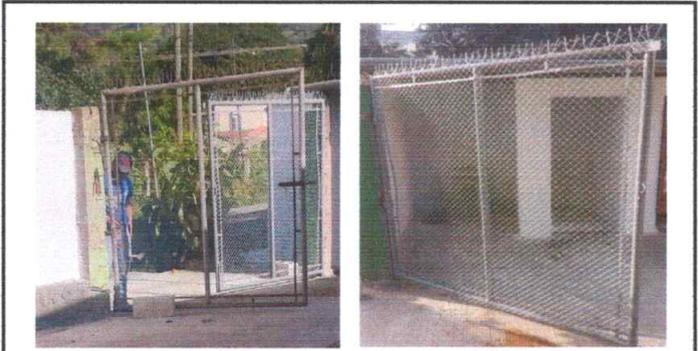
Foto 5: MANTENIMIENTO APORTONES: Sustitucion de malla y tubo quebrado
