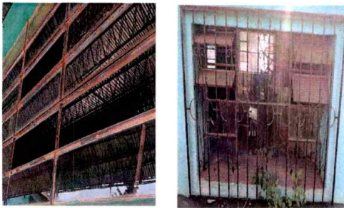
Foto 3: VENTANAS: Sustitucion de ventanas en la cocina y las aulas
