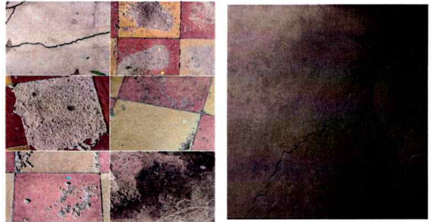
Foto 4: PISO: Sustitucion de piso en la cocina y en los baños
