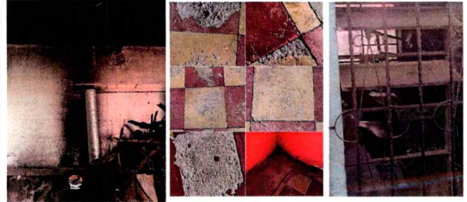
Foto 8: REPARACION O SUSTITUCION DEL AREA DE COCINA. ( Estufas rurales, pilas, ventanas, puertas, chimeneas etc) Reparacion de las planchas, sustitucion del piso y ventanas
