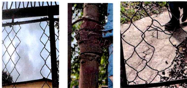
Foto 5: MANTENIMIENTO APORTONES: Sustitucion de malla y tubo quebrado
