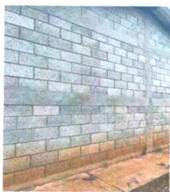
PINTURA EN MUROS INTERIOR Y EXTERIOR
