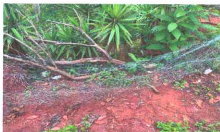
CERCO O MURO PERIMETRAL
