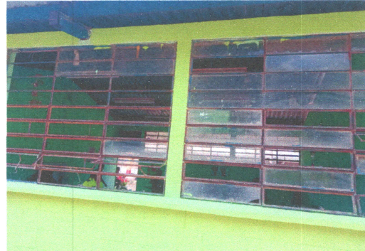
FOTO 2: REPARACION DE VENTANAS
