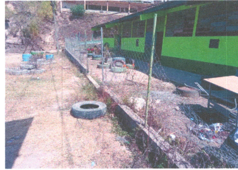
FOTO 8: SUSTITUCIÓN DE MURO PERIMETRAL
