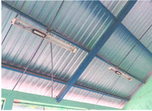
Foto 7: REPARACION DE SISTEMA ELECTRICO
