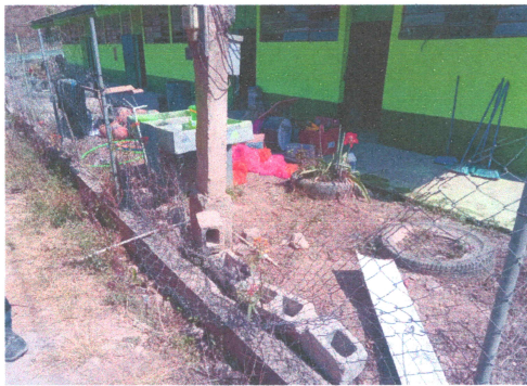
Foto: 5 MANTENIMIENTO A PORTONES
