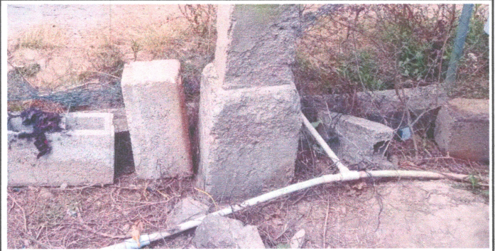
Foto: 6 REPARACION DE RED DE DRENAJES Y RED DE AGUA POTABLE
