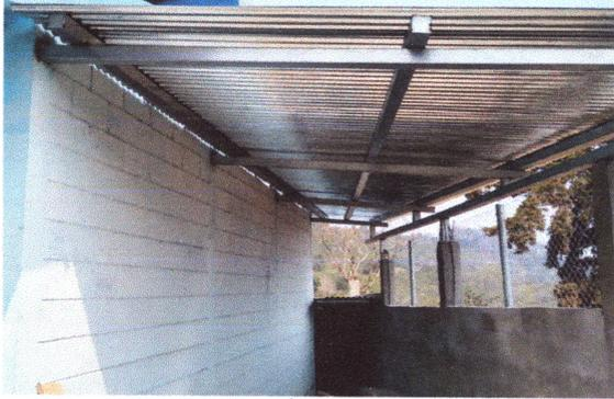
FOTO 1: Sustitución de cubierta de lamina finalizada.
