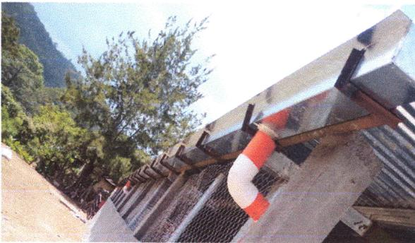
FOTO 5: Sustitución de canales y tubería de caídas de agua
