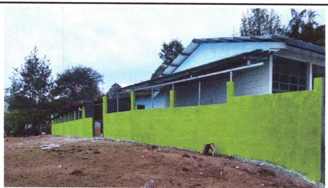
FOTO 4: Pintura de muros exterior e inetrio finalizado.
