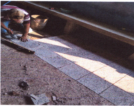
FOTO 3: Sustrucción de una parte del piso de la escuela en proceso.
