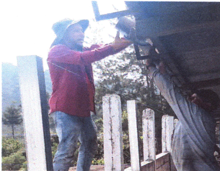
FOTO 5: Sustrucción de canales y tubería de caídas de agua en proceso.
