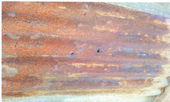
Foto1: SUSTITUCION DE CUBIERTA DE LAMINA DEL TECHO DE LA ESCUELA.
