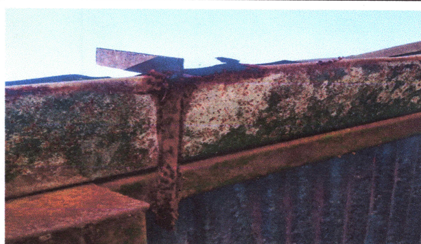
FOTO 2: REPARACION Y PINTURA DE LA COSTANERA DEL TECHO LA ESCUELA.
