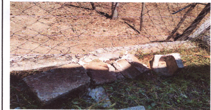
Foto7: REPARACION DEL MURO PERIMETRAL DE LA ESCUELA.
