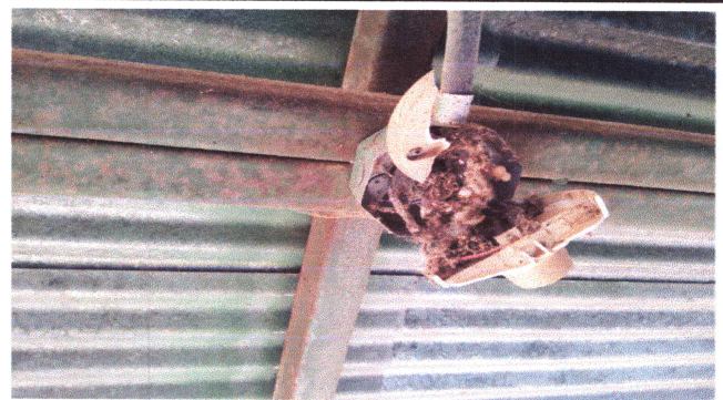
FOTO8: REPARACION DEL SISTEMA ELECTRICO DE LA ESCUELA.
