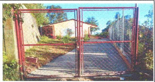
Foto 2: En las fotografías se aprecia la culminación total de reparación del portón de la escuela (cambio de malla y pintura).
