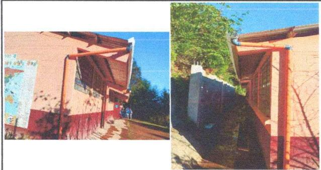
Foto1: En las fotografías se aprecia el acabado total de colocación de canales pluviales, enfrente y detrás de los salones de clases, esto incluye: bajadas de agua.
