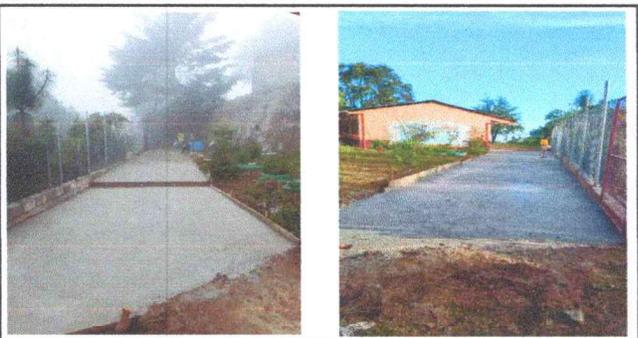
Foto 6: Se observa el acabado de la losa de patio en su totalidad, una fundición de 100 metros cuadrados.
