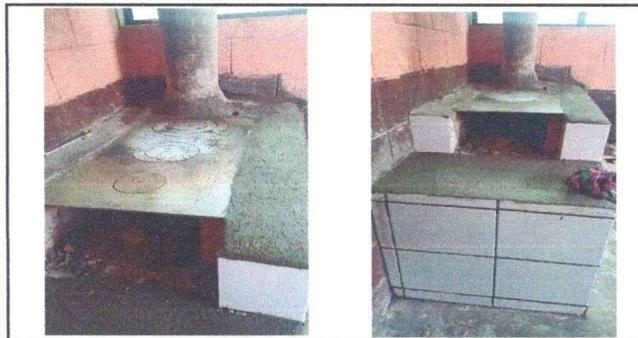
Foto 5: En las fotografías se observa la reparación completa de una estufa rural: cambio de plancha, azulejo y mantenimiento de chimenea.
