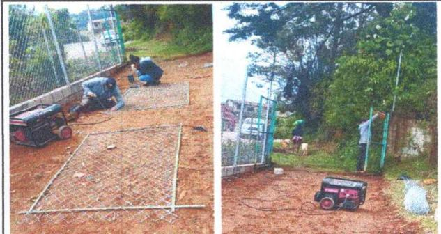
Foto 2: En las fotografías se aprecia el proceso de reparación del portón de la escuela (cambio de malla y pintura).
