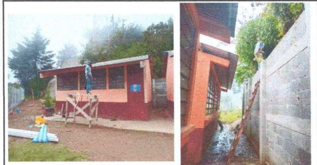
Foto1: En las fotografías se aprecia el proceso de colocación de canales pluviales, enfrente y detrás de los salones de clases, esto incluye: bajadas de agua
