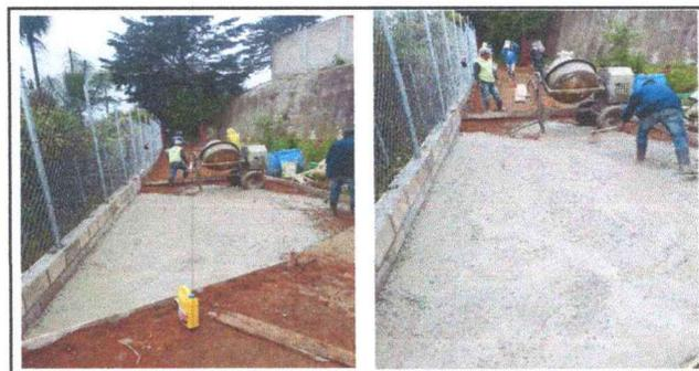
Foto 6: En las fotografías se observa el proceso de fundición de la 100 metros de la losa de patio.
