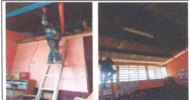
Foto 4: Se observa el proceso de cambio del sistema del cableado eléctrico. Dicho cambio se realiza en: dirección, bodega, cocina, dos aulas y exteriores de la escuela.
