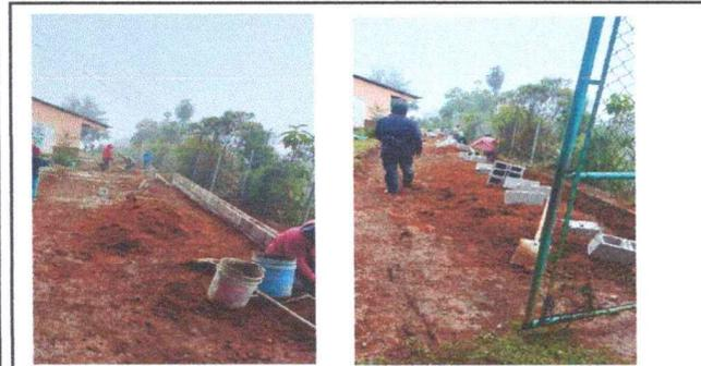
Foto 3: en las fotografías se aprecia el proceso de la reparación de la malla perimetral de 25 metros.
