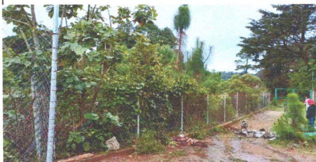
Foto 3: el cerco perimetral se esta hundiendo, por lo tanto, se necesita reparación de 25 metros.
