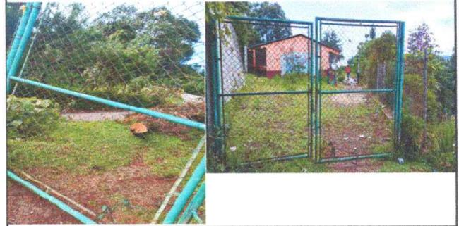
Foto 2: Se aprecia la necesidad de reparación del portón por que la malla esta rota, lo cual permite que personas ajenas a la institución entren a consumir bebidas alcohólicas.
