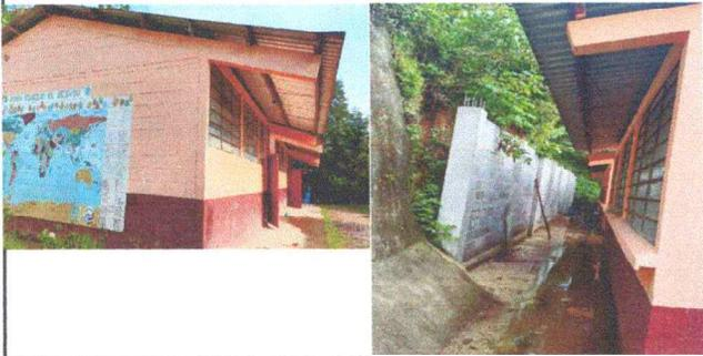
Foto1: En las fotografías se aprecia la necesidad de colocar canales pluviales en la lamina de dos salones de clases, dirección y cocina, debido a que el agua se reposa en el patio de la escuela y en la parte de
